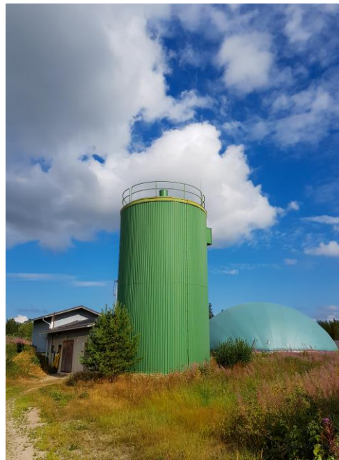
Perinteinen sekoittava "märkämädätykseen" perustuva Metener Oy:n rakentama reaktori Halsualla. Reaktorin tilavuus n. 250 m 3 . Laitoksella käsitellään sianlietettä ja puhdistamolietettä. Vuotuinen käsittelymäärä n. 5000-6000m 3 .
