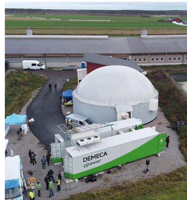
Demeca Oy:n rakentama kiintomädätyslaitos Toholammilla Ilpo Wennströmin tilalla. Reaktorin koko n. 600 m 3 . Käsiteltävinä syötteinä lietelanta, kuivalanta ja ylijäämärehu. Mädate separoidaan.
