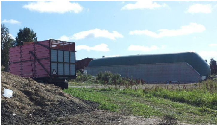
Kuivamädätykseen perustuva Metener Oy:n rakentama reaktori Kalmarin tilalla Leppävedellä. Jatkuva kaasuteho säädettävissä 50-150 kW välillä.
