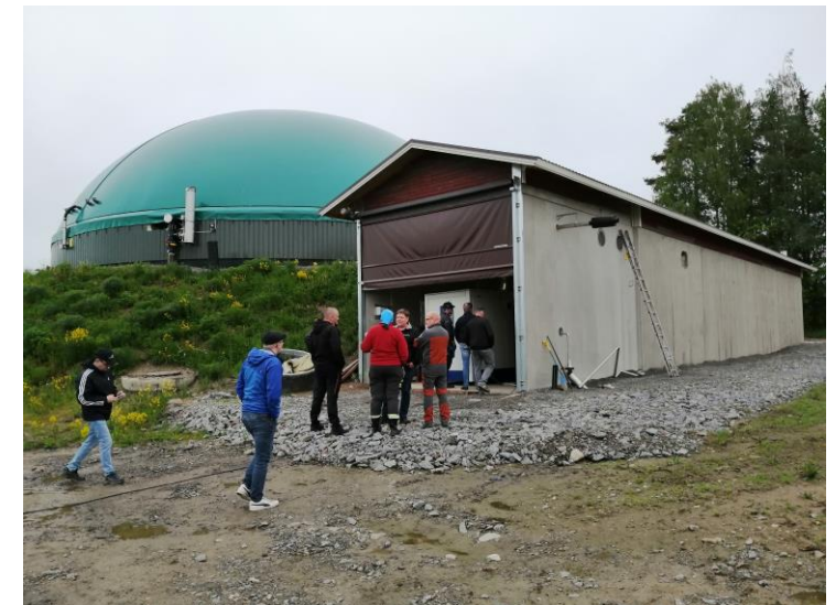
Demeca Oy:n rakentama kiintomädätyslaitos Toholammilla Ilpo Wennströmin tilalla. Reaktorin koko n. 600 m 3 . Käsiteltävinä syötteinä lietelanta, kuivalanta ja ylijäämärehu. Mädate separoidaan.
